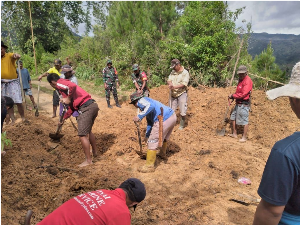
Babinsa bersama warga tampak kompak bahu-membahu membersihkan saluran air yang tertutup oleh lumpur sehingga mengganggu aliran air tidak lancar.
